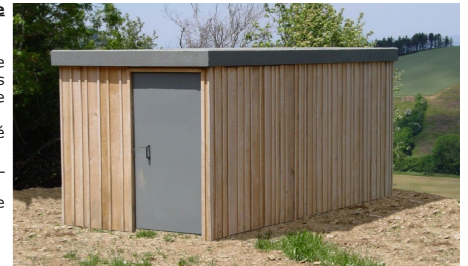
Exemple d'habillage bois d'un poste de livraison - projet VALECO
